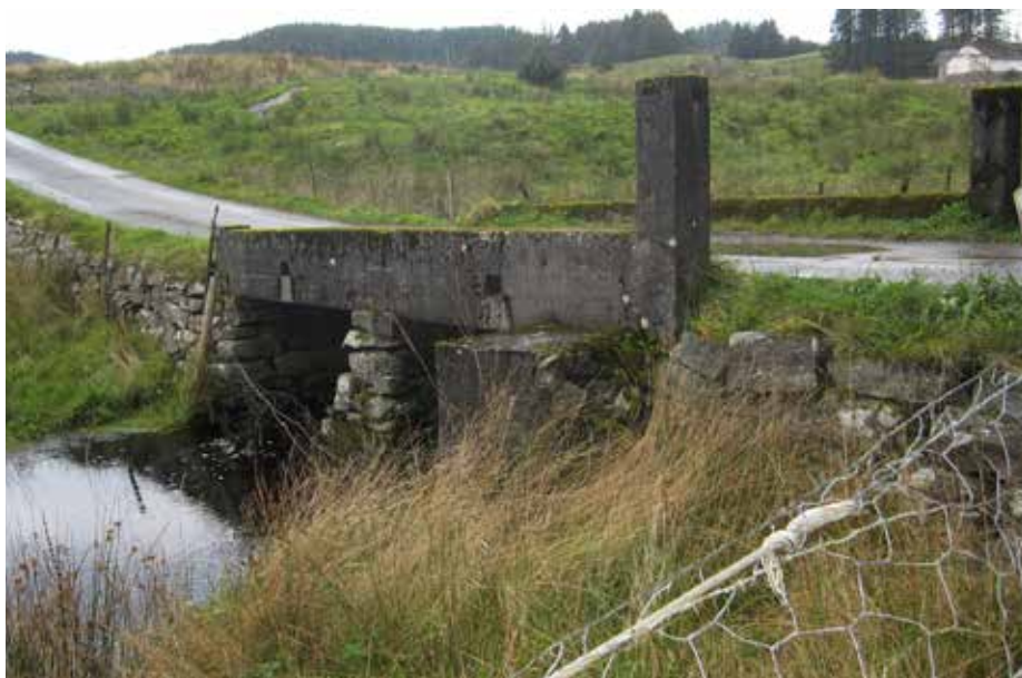
Bru over Aksneselva, pillarer fra gamle kirkevegen.
