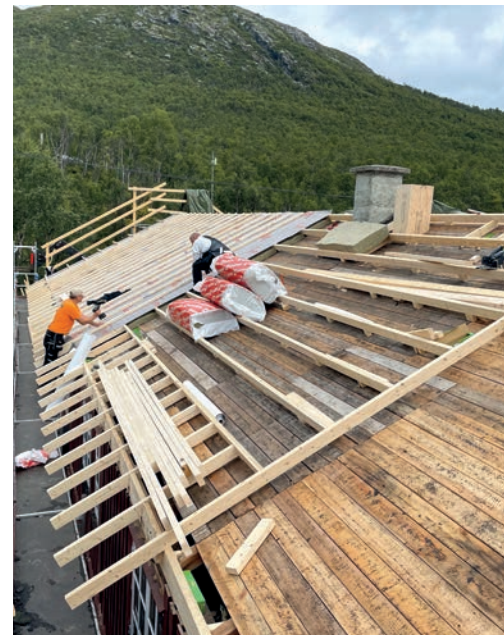
Arbeidene med avretting, tilleggsisolering og bygging av ny taktro.
