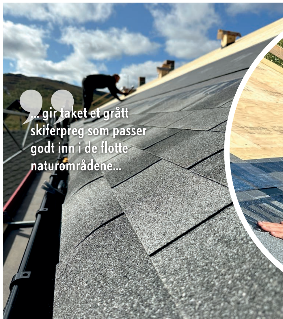
Montering av Isola Takshingel Rett – grå struktur.
