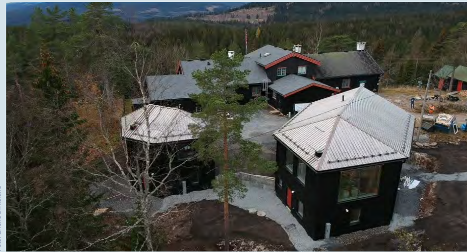
Byggeprosjektet på Kobberhaughytta ble ferdigstilt i desember. To nye bygg er kommet opp, et losjibyg med 30 soveplasser og ny bestyrerboli.
