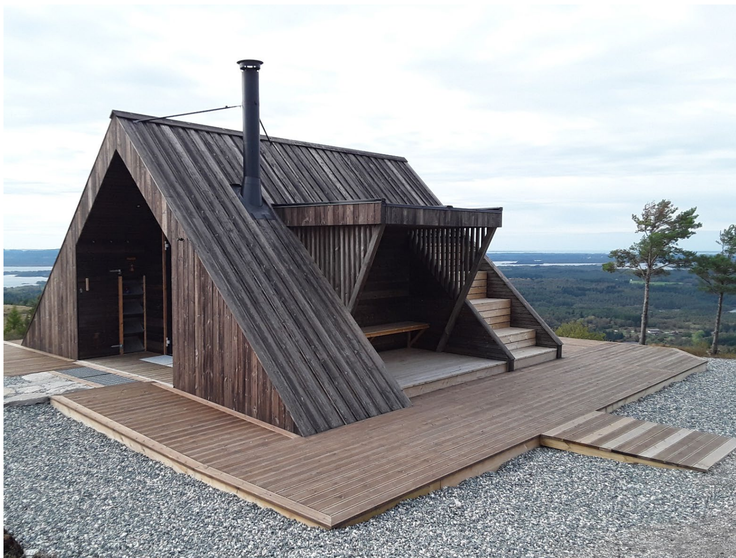
Rampe fra turvei samt platting rundt dagsturhytte Vardebu sikrer at alle kan komme inn. Foto: Linda Fongaard
