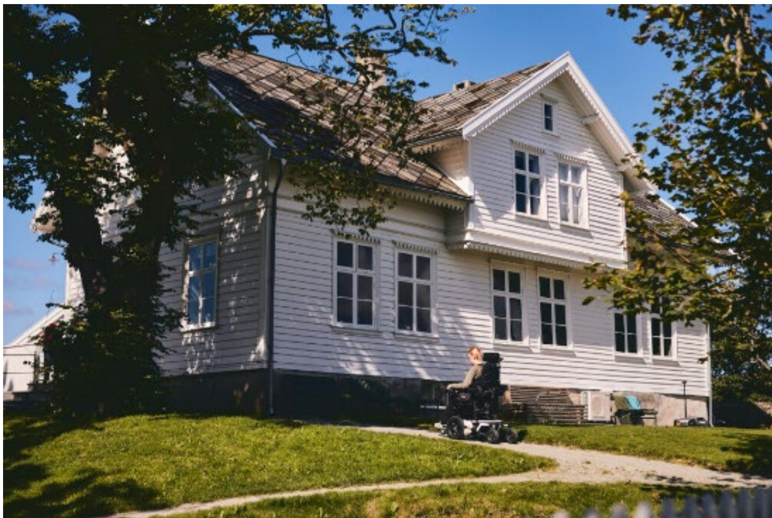
Adkomst til Villa Vibrandsøy. Foto Haakon Nordvik
