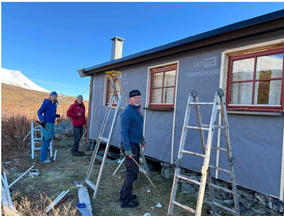
Bytte av kledning og etterisolering på nye Rostahytta. Foto: Odd-Arne Solvang
