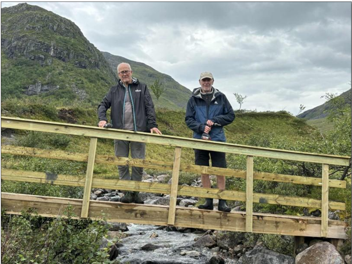
Dugnadsgruppa Kjerringhaugens Venner i Rauma har utbedret stien til Skorgedalsbu med flere klopper, samt ferdigsilt klopper og ny bro mellom Vistdal (Langedalen) og Måsvassbu. Foto: Arne Eide.
