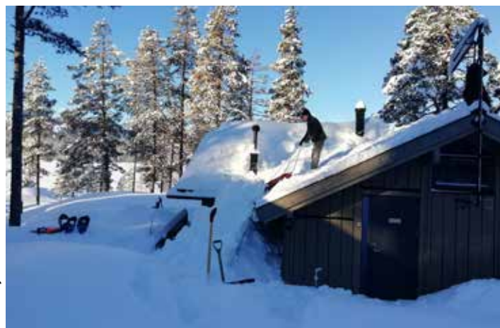
Veldig mye snø på taket til Fønhuskoia måtte måkes. De frivillige står på!
