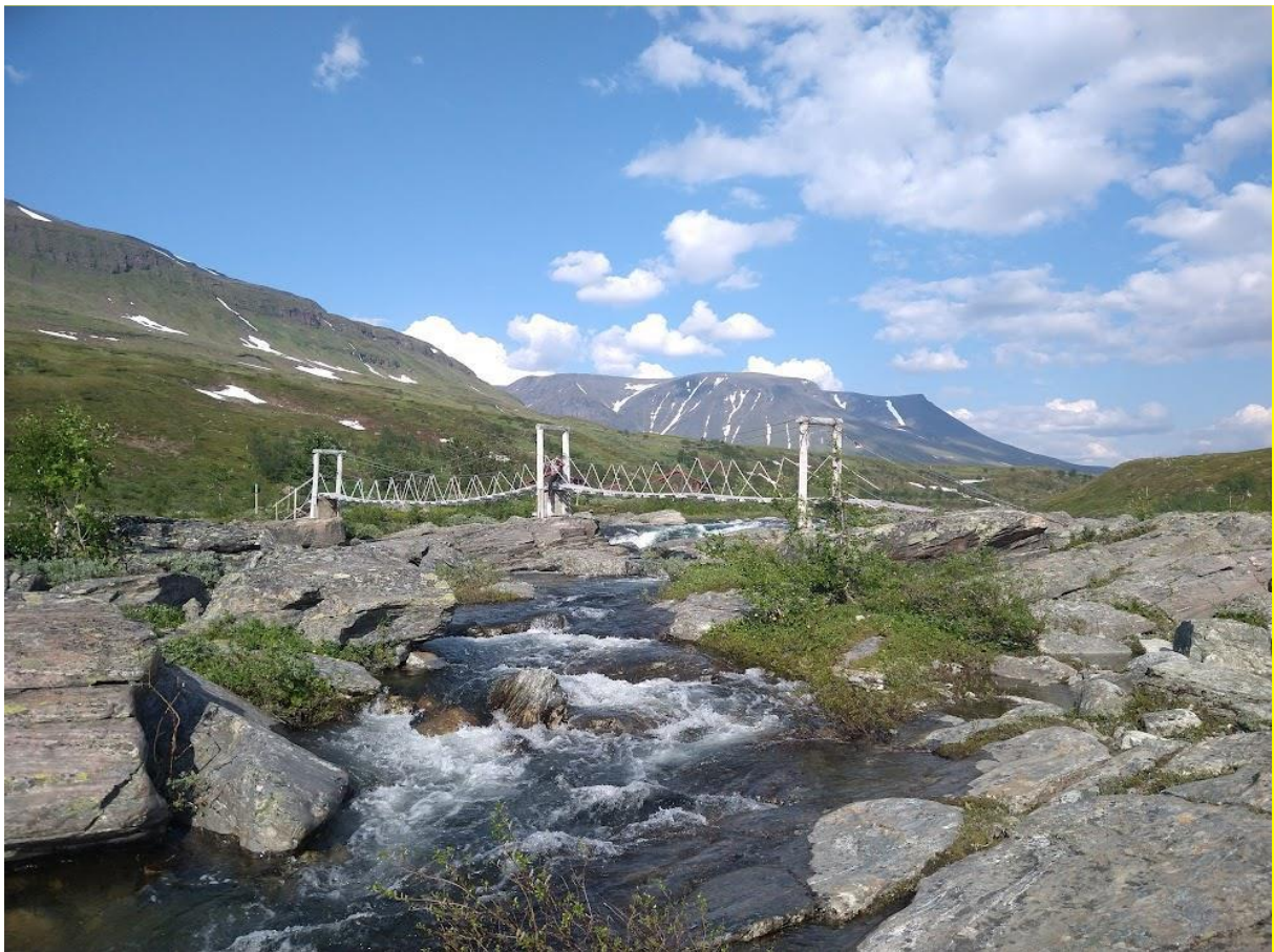
Brua over Rostaelva. Foto: Jens Breivik
