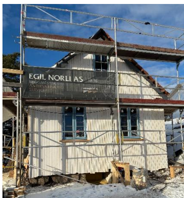
Hovedhuset er kledd og fått nye vinduer
