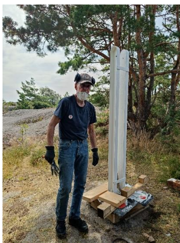
Reparasjon av fundament for ny flaggstang
