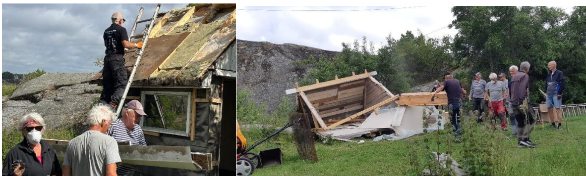
Den gamle boden på stranda blir revet. Her skal ny badstue bygges.
