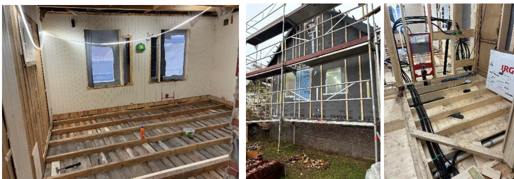
Byggmester Norli rehabiliterer hovedhuset. Vann og avløp samt strømkabler legges.
