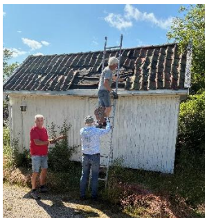
Rivning av bod og fristilling av fundament for nytt sanitærbygg
