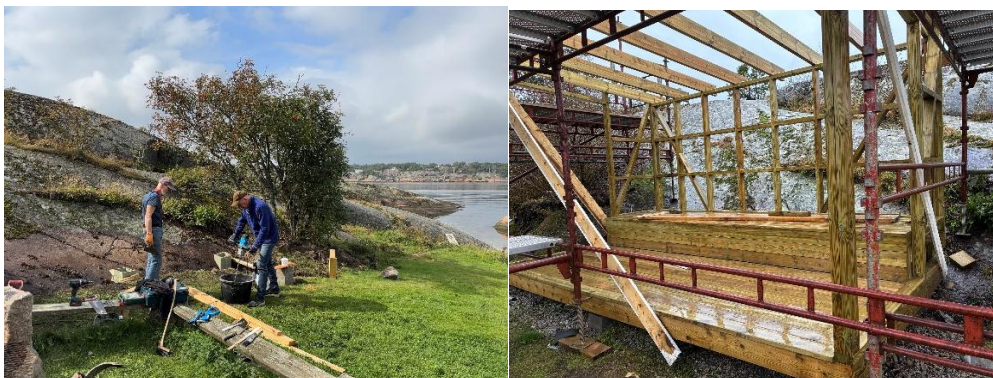
Her støpes det fundament for gapahuken. Greåker VGS bygger.
