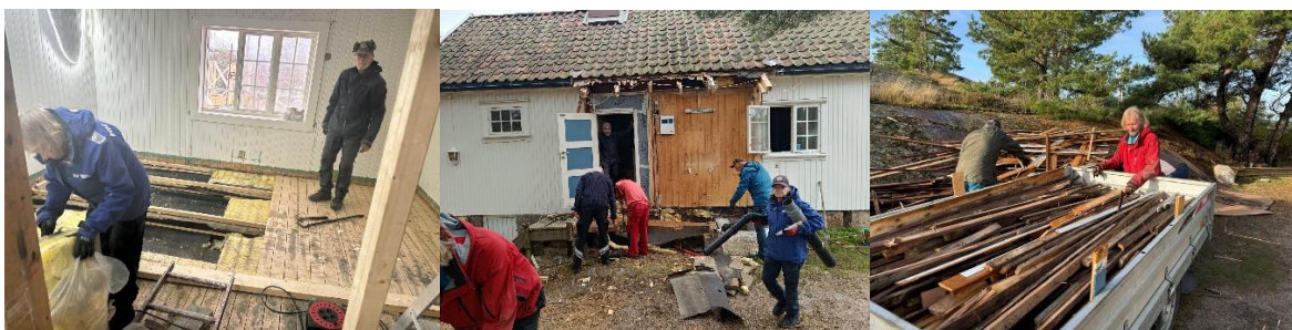
Rivning av gulv og vegger og inngangspartiet i hovedhuset. Alt må kjøres på fyllinga.
