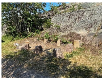
Rivning av bod og fristilling av fundament for nytt sanitærbygg
