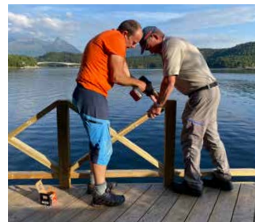
Godt samarbeid er nøkkelen til godt resultat. Sindre og Gunnar skrur rekkverk. Foto: Tone Drabløs.
