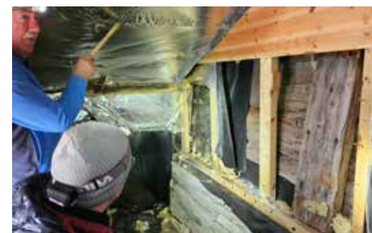
Åsmund Skålvik har revet panel og opprinnelige tømmervegger kommer frem i dagen igjen.
