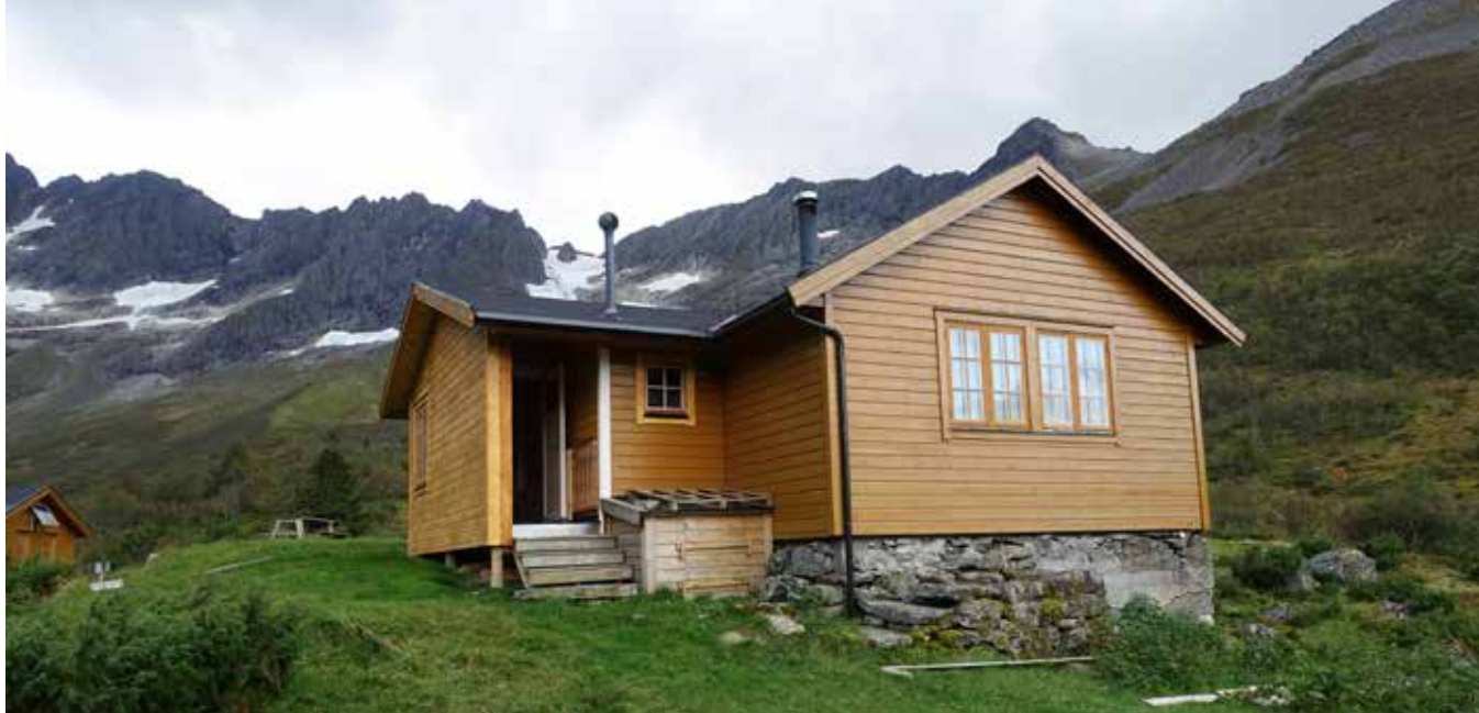
Velleseter har fått nytt inngangsparti og større gang i 2023. Foto: Egil Astad.
