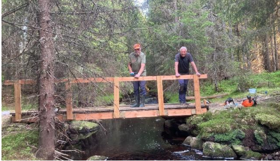
Vedlikehold på bru over Bjønnbekken ved Gryllingsætra
