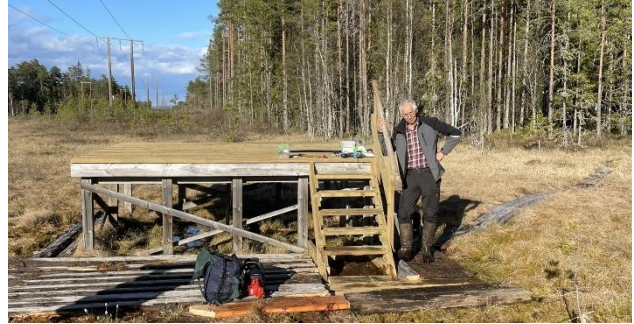
Ny plattning og trapp på skafottet
