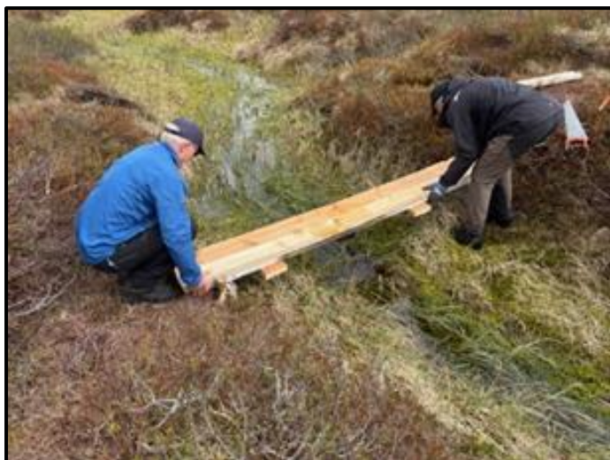
Rune Bye og Helge Stikbakke reparerer ei lita bru over bekk på Rondanestien ved Djupdalen. Foto: Arnstein Hals
