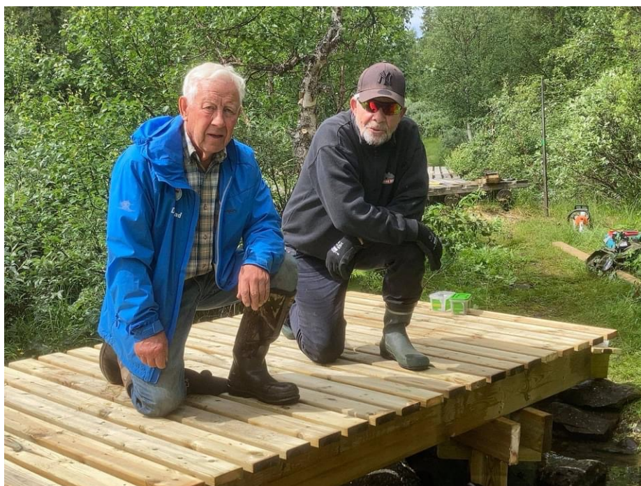
Bygging av flott, ny bru over elva Hynna, ved utløpet av Hornsjøen i juli.
