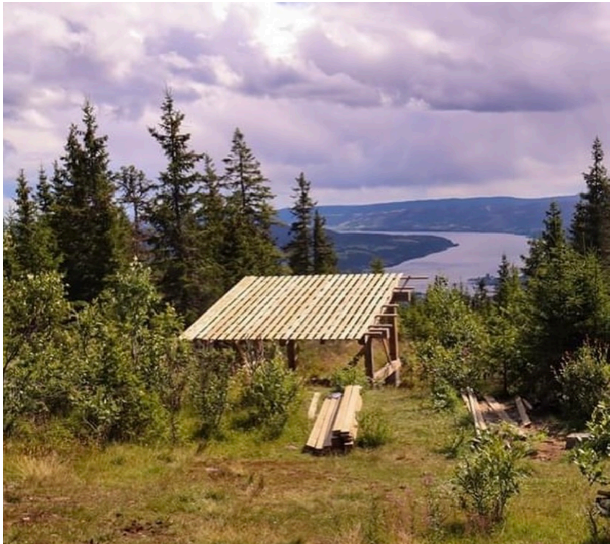
Her er gaphuken på Balbergkampen under oppføring. Foto: Tirill B. Sæverud
