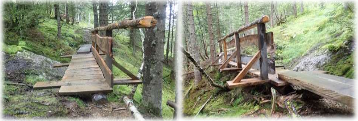
Eksempel på vanleg bru med 2 underliggjande rundstokkar.
