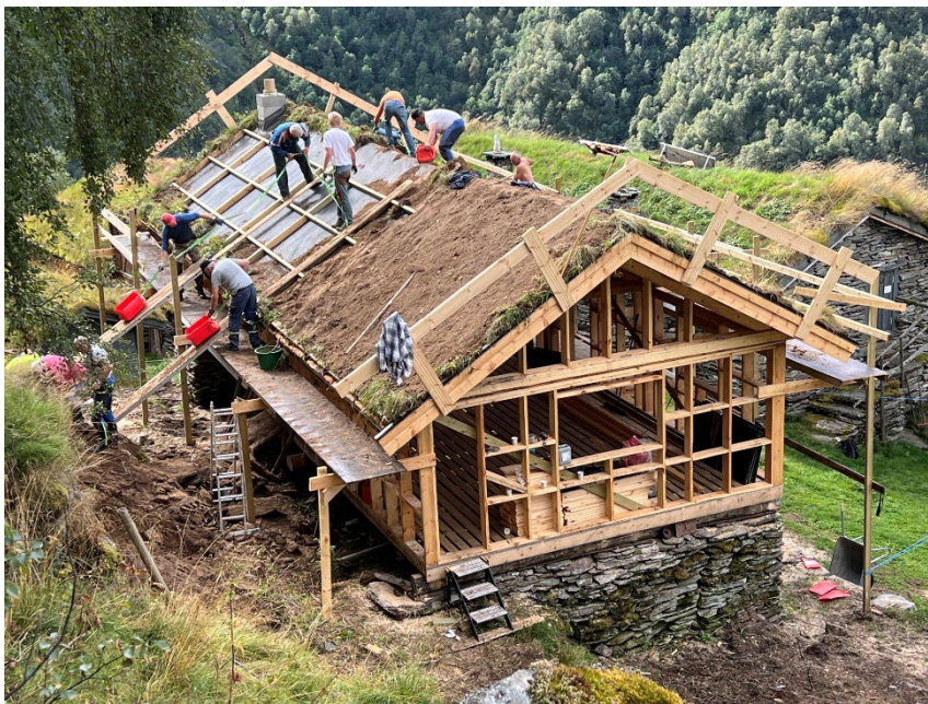
Dugnadsgjeng jobbar på taket av nye Løa på Fuglesteg. Foto: Stein Bugge Næss
