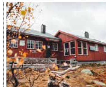
LAKKENSTOVA 845 moh 32 senger / Bygget/renovert: 1985/2011
