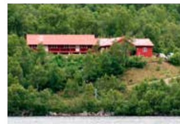
BJØRNEVASS- HYTTA 820 moh 26 senger / □ Bygget/renovert: 1889/2009
