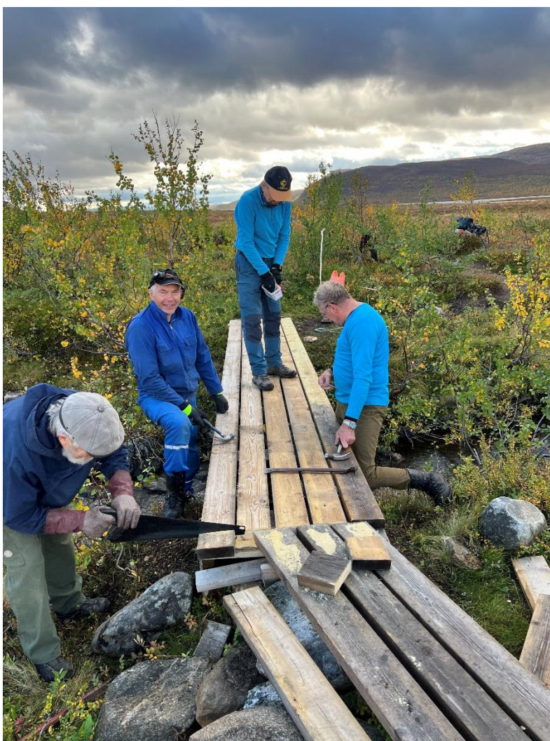
Reparasjon av kort plankebru. Foto: Pål Tengedal
