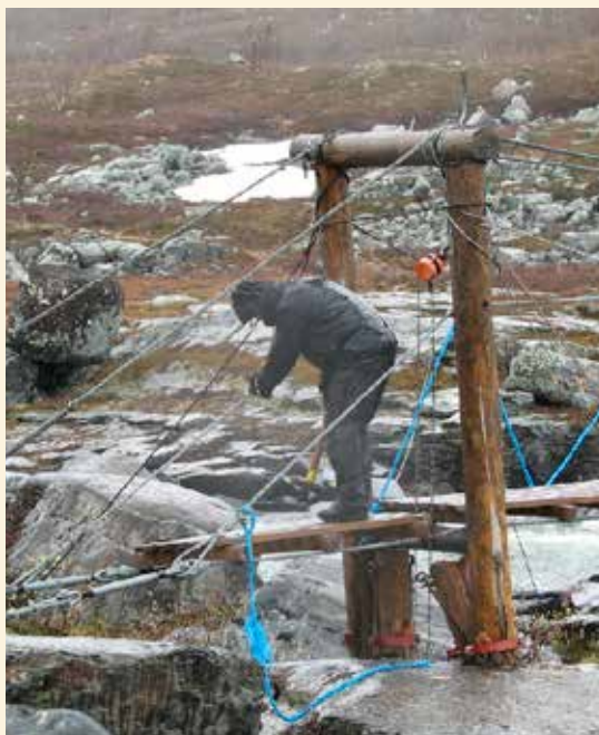
Hengebrua ved Rostahytta etter reparasjon.
