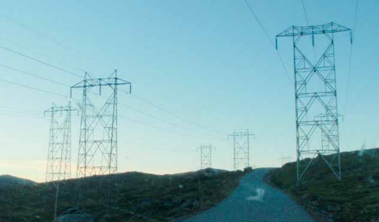
Nye gigantiske kraftlinjer skal bygges mellom landsdelene. Foto: Harald Bohne
