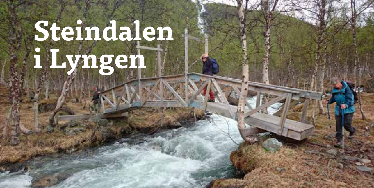
Brua over Steindalselva
