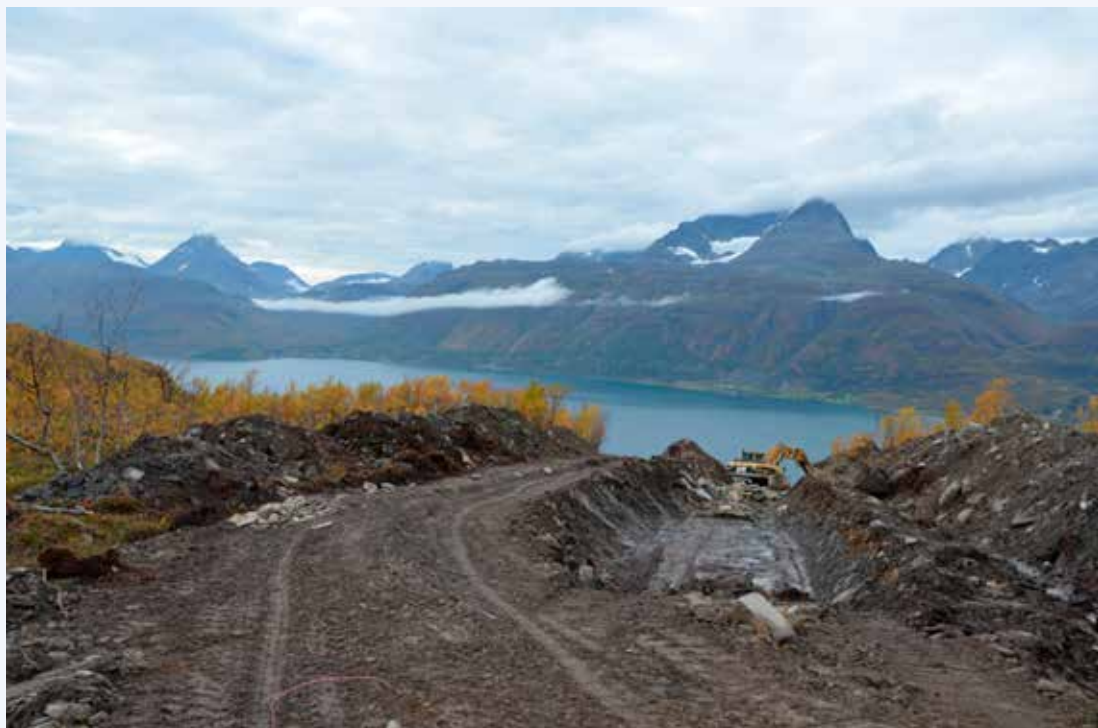
Bentsfjordelva i Storfjord og småkraftutbygginga der. Foto: Tore Figenschau
