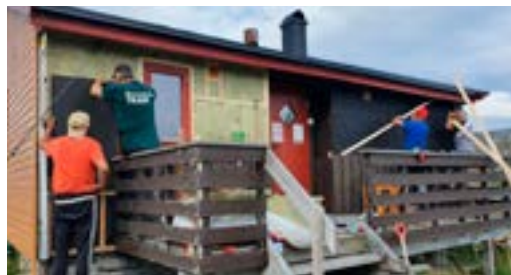
Alf, Odd, Valter og Lars Ivar skifter kledning på Ringvassbu. Foto Ellen Marie Ingulfsvann
