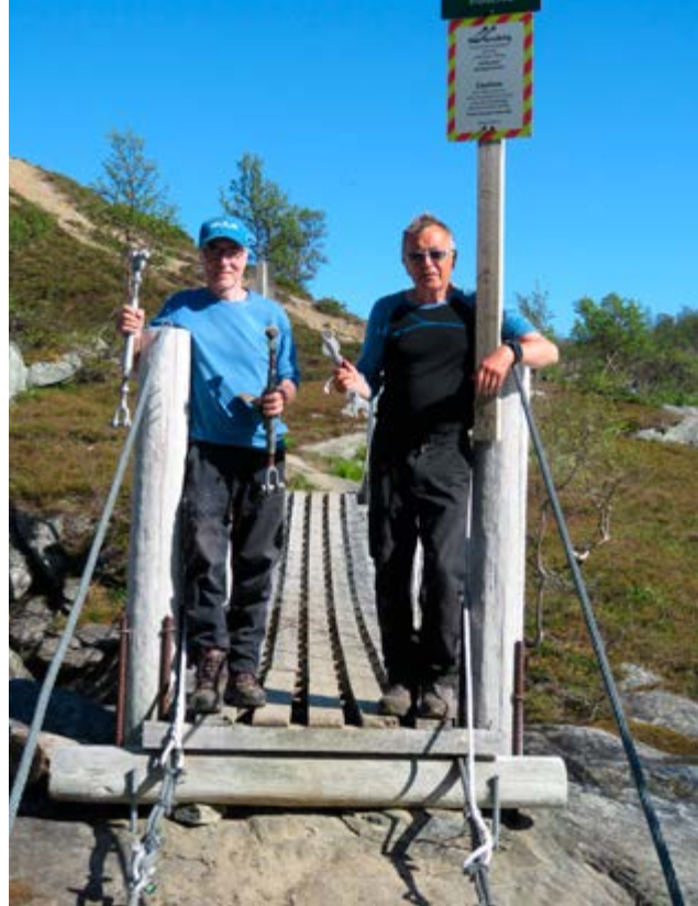
Fornøyde etter reparasjon Trollelvbrua. Paul Strandli & Reidar Skarshaug.
