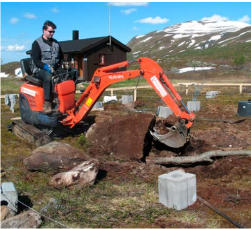
Gravemaskina var i flittig bruk. Ole Wille ved spakene
