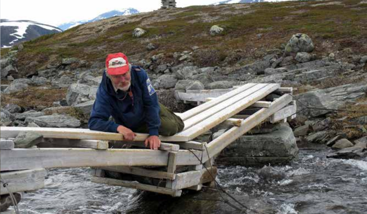
Bjarne Bockelie reparerer bru
