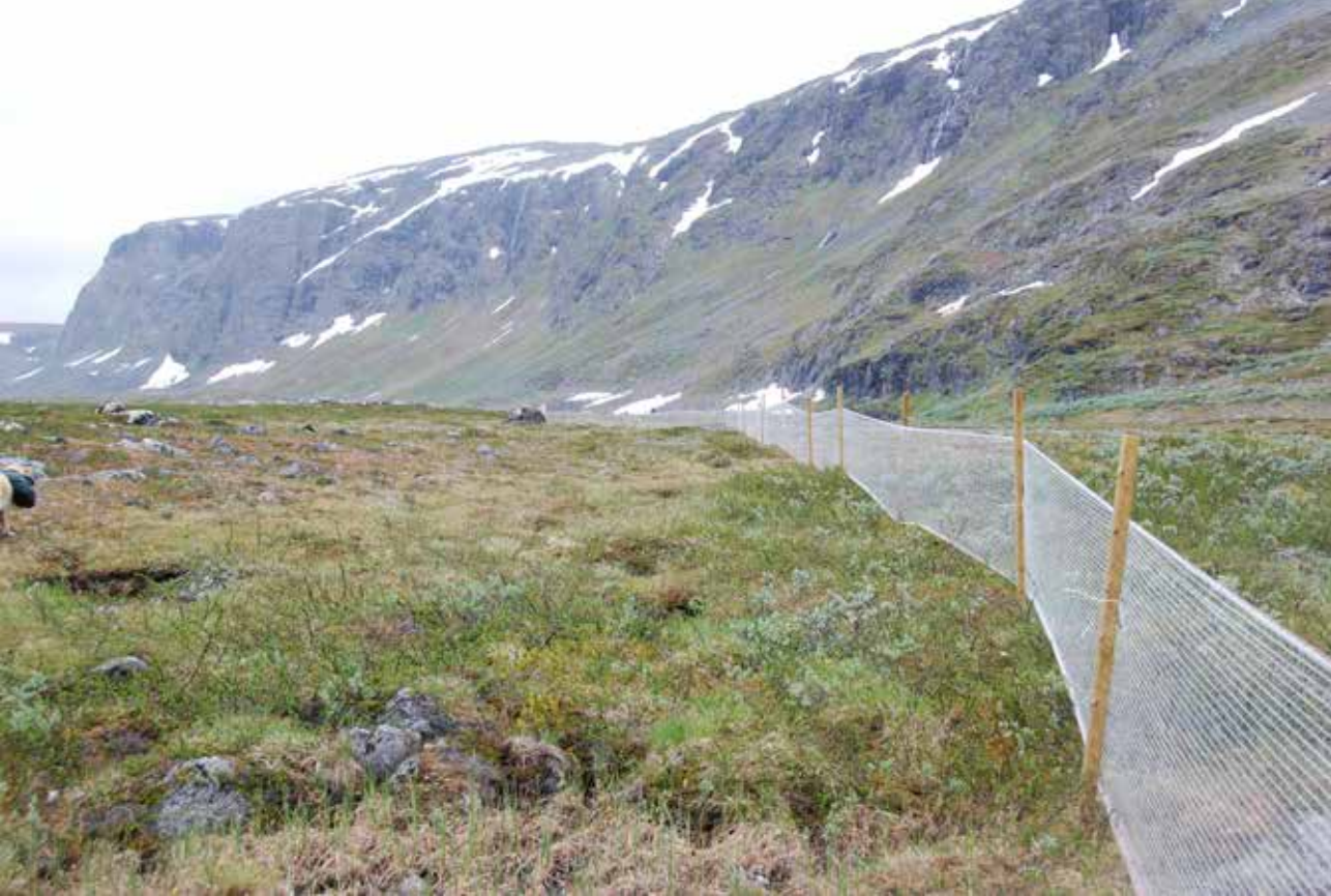
Sperregjerdet slik det skiller to svenske samebyers beiteland. Foto: Hans Prestbakmo
