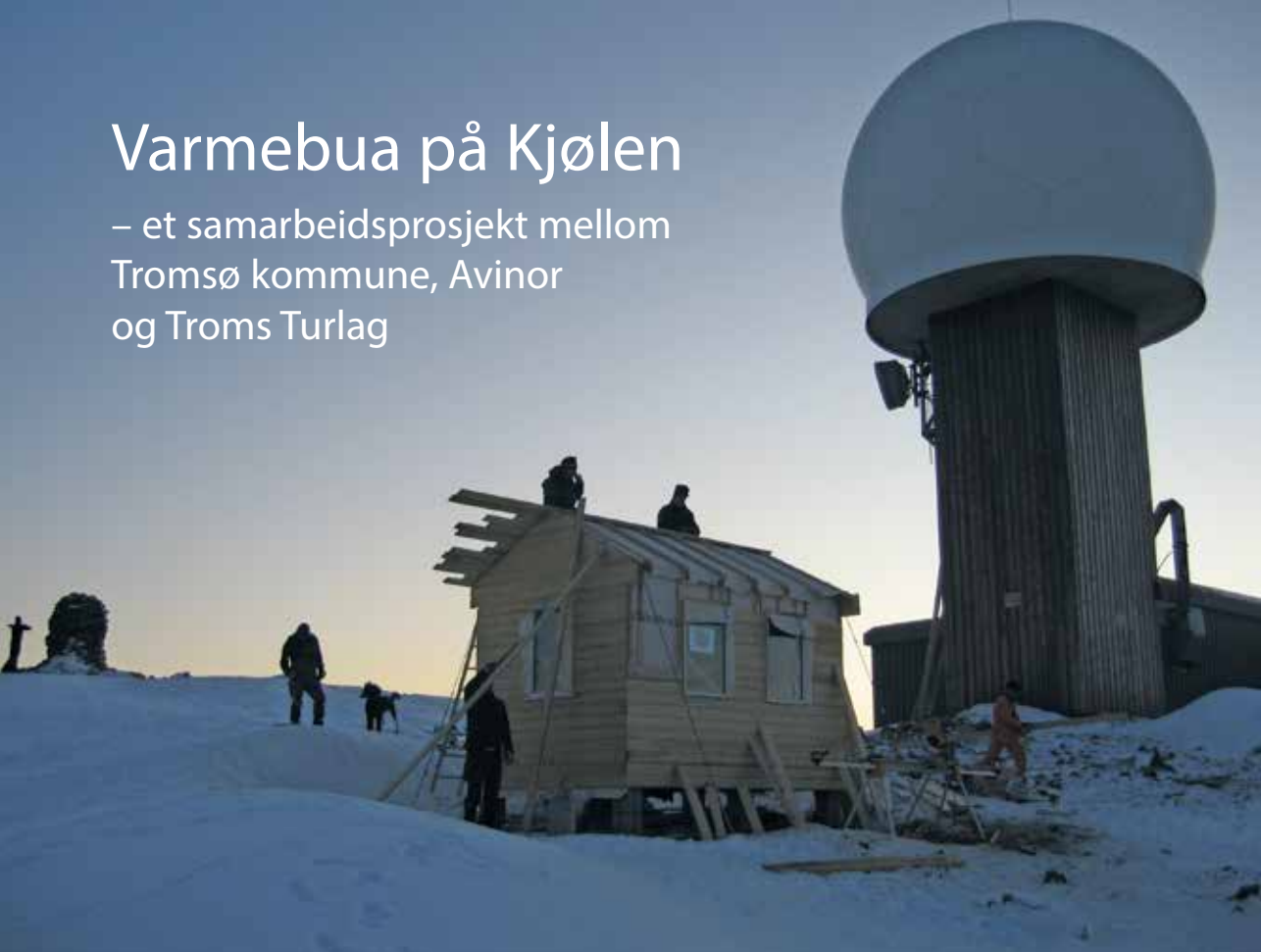
Varmebuga under oppføring. Foto: Ole Wille
