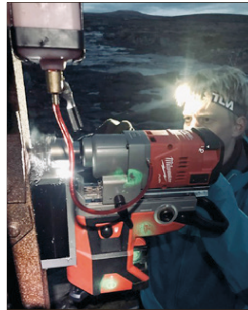
Hallvard setter på metallforsterkninger han selv har tegnet og beregnet.
