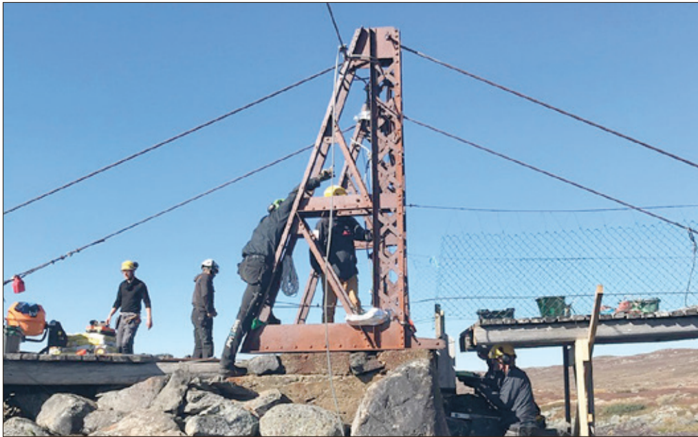
Audun og Øystein forsterker fundamentet under brua, Ole og Jan bygger om tårnet, Ole og Eirik bygger tilleggsbrua
