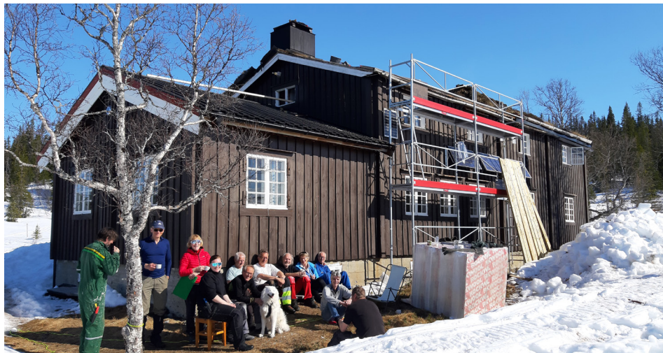
En liten rastepause fra arbeid med å fikse opp taket på Schulzhytta, dugnad i April. Foto: Eskil Følstad
