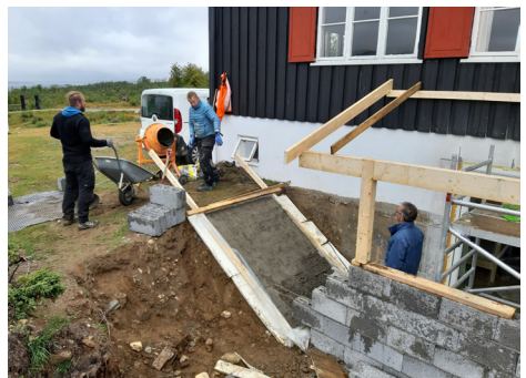
Ny kjelleringang på Nedalshytta. Foto: Eskil Følstad
