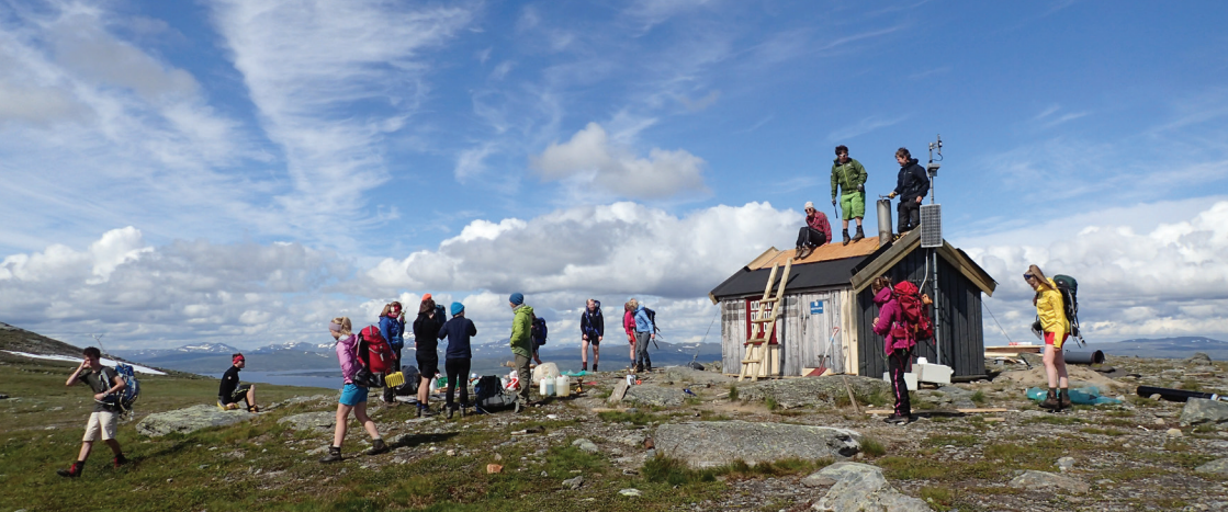
En dugnadsgjeng fra DNTung Trøndelag totalrenoverte Fiskåhøgda i 2017. Foto: Egil Andreas Behrens
