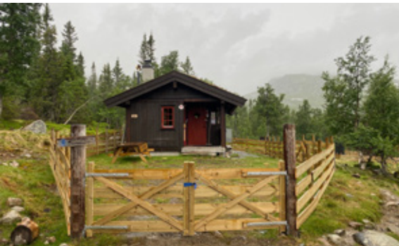
Gjerdet rundt Veslekrak er ferdig.
