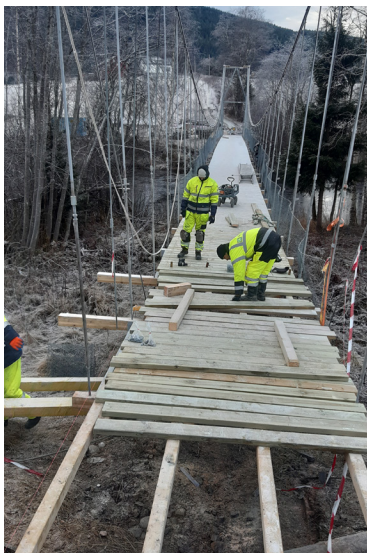
Arbeidet på Borglund hengebru fullføres
