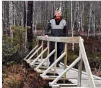
Kjetil på den nye brua over Urdevasselva. Foto: Axel Holt
