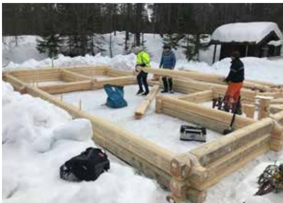
Lafting av nye Hovinkoia vinteren 2018. Foto: Tom-Erik Bakkely Aasheim
