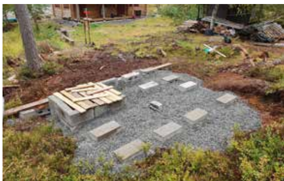
Grunnarbeidet på Hovinkoia. Foto: Kjetil Sudgarden
