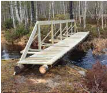
Ny bru over Urdevasselva bygd på dugnad. Foto: Kjetil Sudgarden
