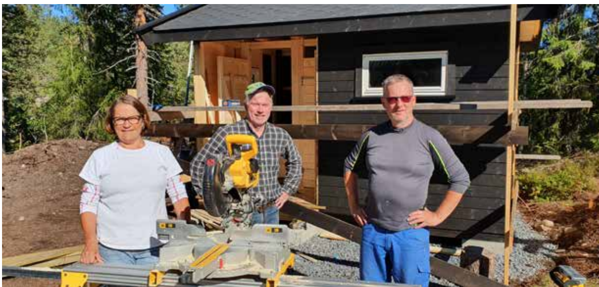
Taktekking og beising på det nye uthuset på Vikerkoia. Fra venstre: Tove Møller, Jan Gunnar Hagen, Odd Magne Nygård. Foto: Kjetil Sudgarden
