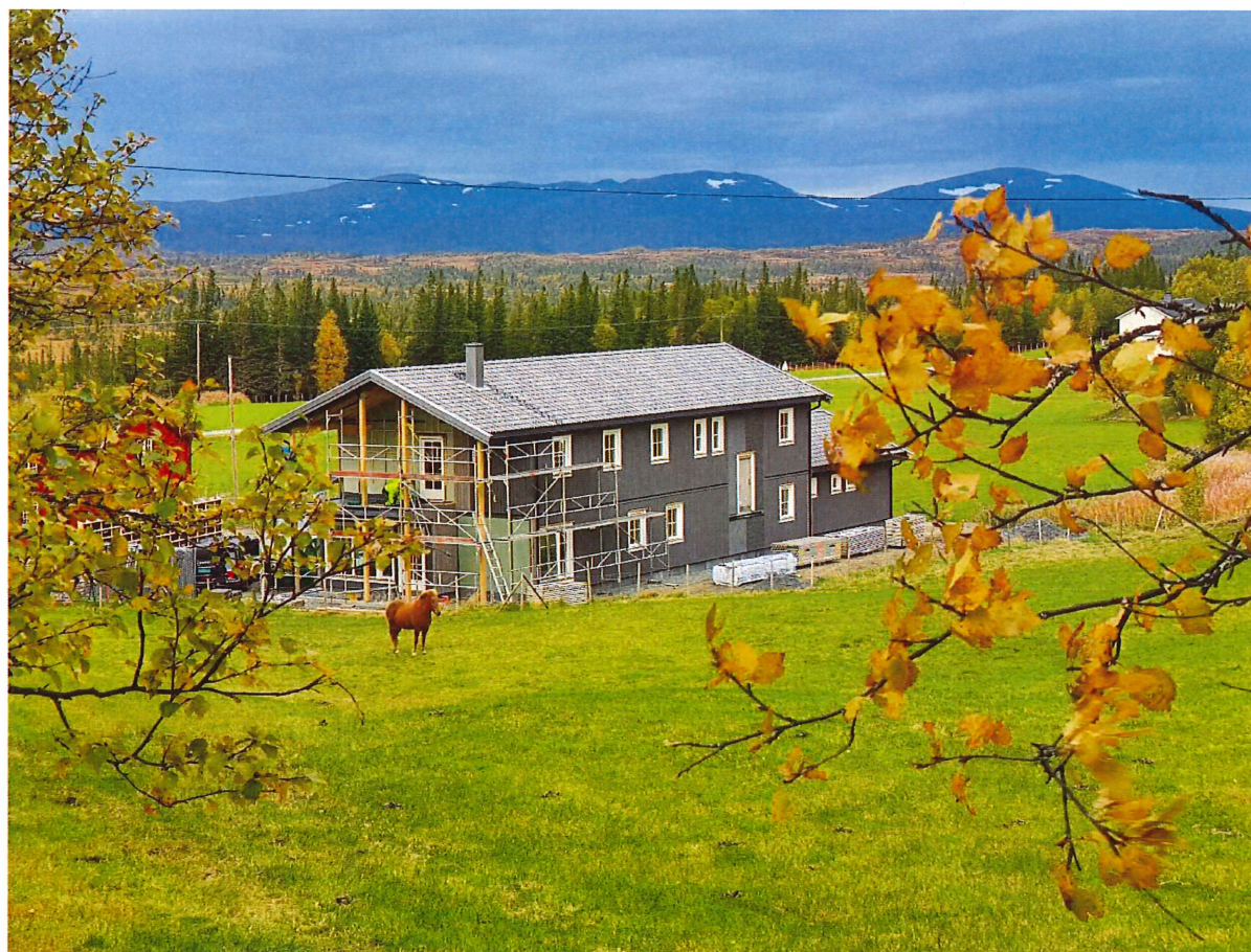
Bygging av Stordalshytta, september 2021. Foto: Nina Pettersen
